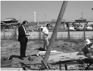
東邦テナックス汚泥の掘削調査現場で (北島町)
